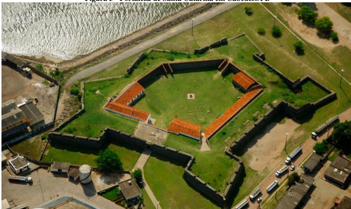
Figura 3 - Fortaleza de Santa Catarina em Cabedelo/PB
