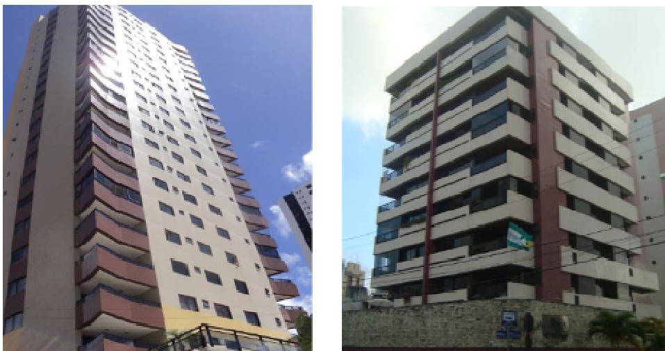
Figura 2: Edificações da amostra – presença de varandas.
