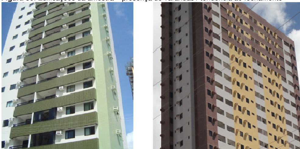
Figura 36: Edificações da amostra – presença de varandas / tendência ao fechamento
