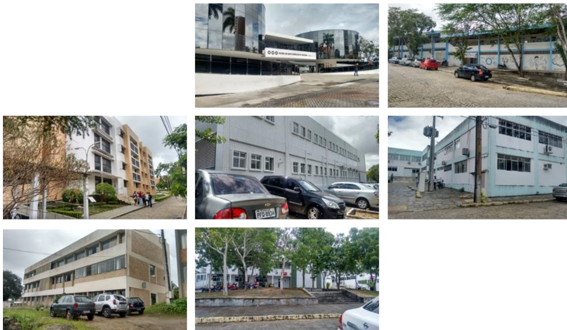
Figura 7 - Edificações utilizadas nos experimentos de campo
