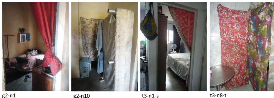
Figura Ap. 9 - [G,T] - Retirada de esquadrias internas, fechamento improvisado com cortina de pano.
