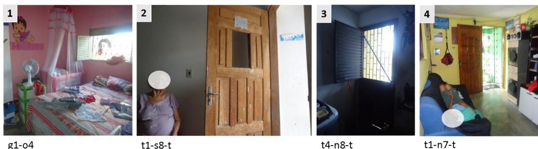
Figura 79 – [G,T] - Segunda estratégia de uso (abrir as esquadrias): 1- janela de quarto; 2 e 4- porta da sala; 3- porta da cozinha.
