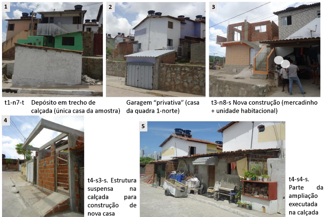
Figura 50 – [T] - Ampliações irregulares, 1- depósito na calçada (casa da amostra), 2,3,4 e 5 diversas irregularidades em casas fora da amostra.
