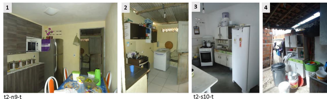
Figura Ap. 19 - [T] 1- cozinha original com parte do mobiliário e retirada de pia; 2- cozinha ampliada com área de serviço compartilhada; 3- retirada da pia na cozinha original; 4- cozinha ampliada com área de serviço compartilhada.
