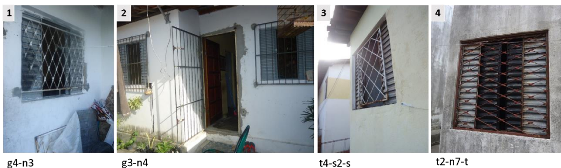
Figura Ap. 3 - [G,T] - 1 e 3 grades aproveitadas com dimensão menor do que a esquadria; 2 e 4 exemplos de inserção de grade.
