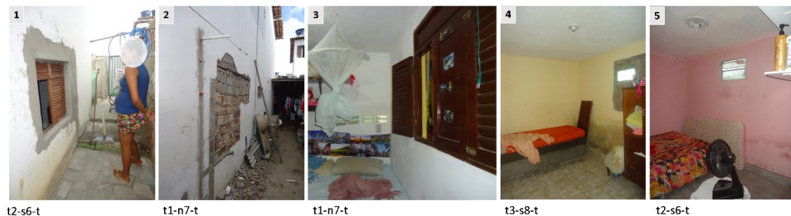
Figura Ap. 12 - [T] - Conflito da localização da janela quarto 1; 1- privacidade comprometida, mas não aceita tirar a janela; 2- cobogó no local como solução; 3- cobogó abaixo da escada e janela voltada para sala; 4 - Tijolo de vidro; 5- janela com peitoril alto.
