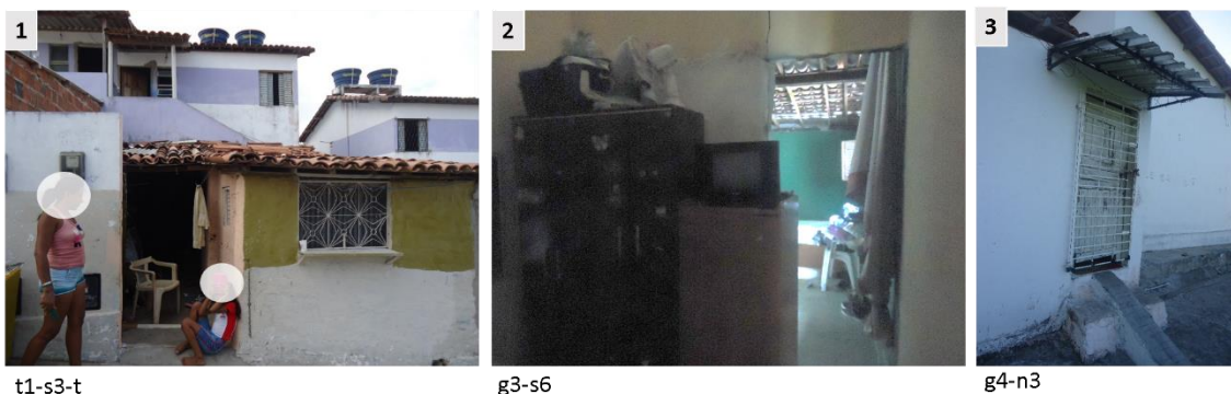
Figura Ap. 17 - [G,T] 1- quarto frontal, acesso pelo terraço; 2- quarto posterior com ligação entre quartos; 3- quarto posterior com acesso para rua.
