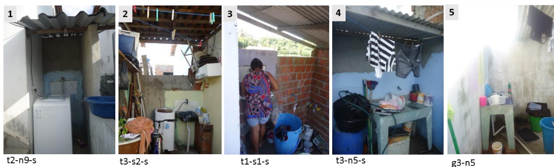
Figura Ap. 24 - 1,2,3,4 área de serviço da unidade superior do Timbó. 1 e 2 -Retirada de tanque para instalação de máquina, 3- apenas cobertura, 4- troca de tanque para melhor material, 5- coberta área de serviço em Gadanho.
