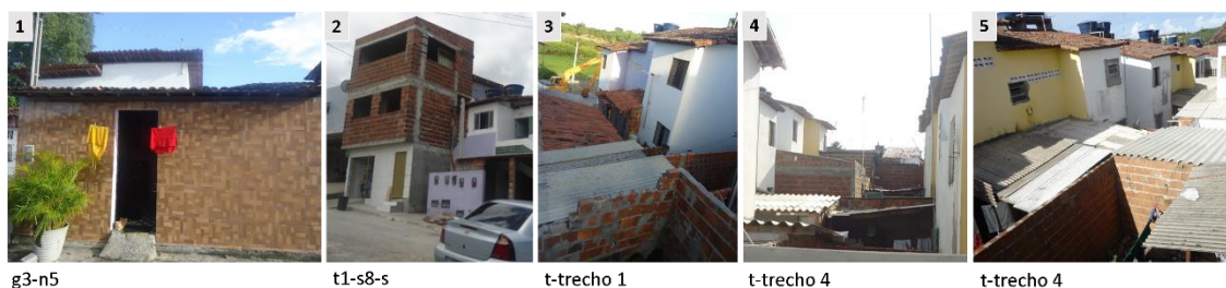
Figura 40 - [G,T] - Cenário das ampliações - paredes frontais e malha fechada entre lotes.
