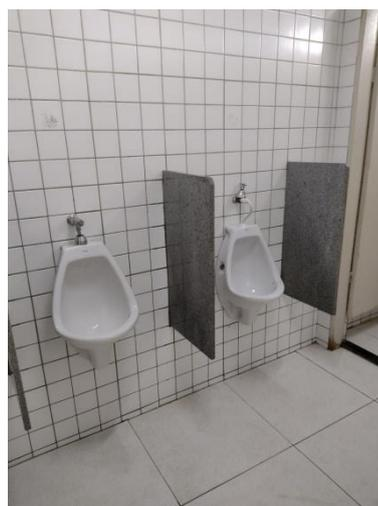
(b) Banheiro Masculino: trocar descarga de sanitário vazando por uma com válvula de pressão
