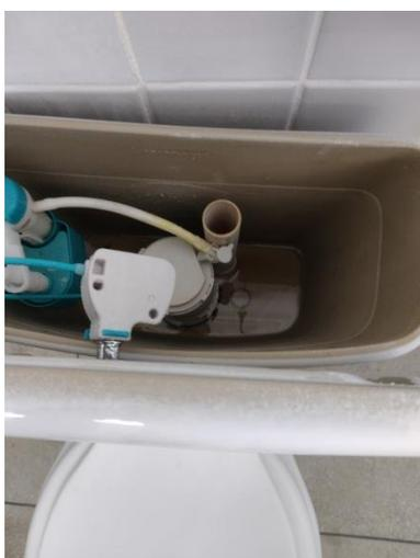
(c) Banheiro Masculino: falta de água na caixa de descarga
