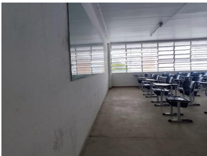
Figura 7 – Janelas basculantes da sala CTJ 201 com vidros quebrados, sem película e com alça de fechamento rompida
