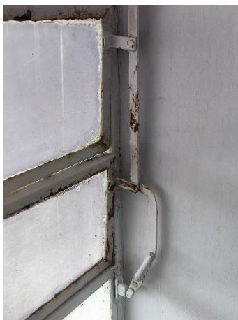
Figura 6 – Detalhe das janelas com oxidação, necessitando de lubrificação e pintura
