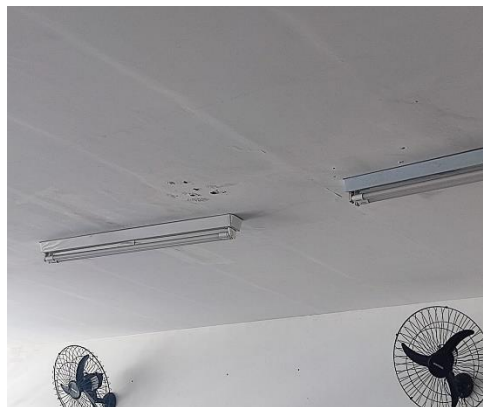
Figura 2 – Problemas no teto das salas do Bloco CTJ
