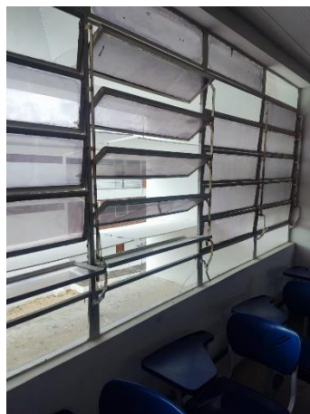
Figura 5 – Janelas basculantes da sala CTJ 201 com vidros quebrados, sem película e com alça de fechamento rompida
