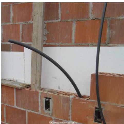
**Figura 12** - Execução de uma junta de dilatação.
