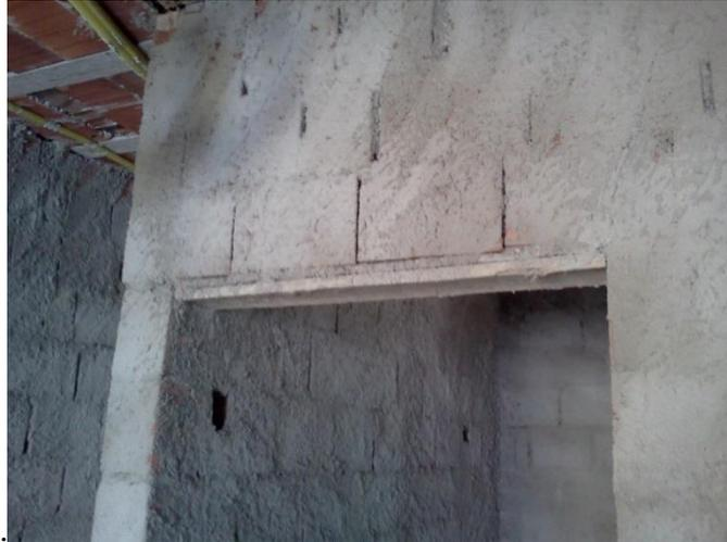
**Figura 06** - Exemplo em obra da utilização da régua pré-moldada.
