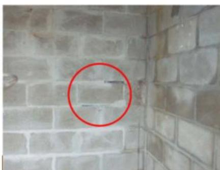
**Figura 04**- Preenchimento das juntas de forma inadequada.
