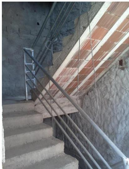
**Figura 23** - Escada pré-moldada treliçada.
