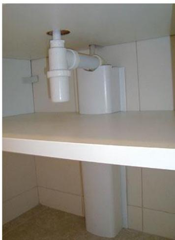
**Figura 27** - Tubulação de esgoto coberta por um painel removível.
