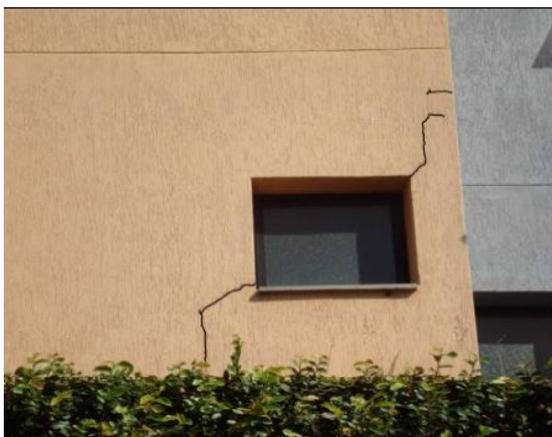
**Figura 17-** Fissuras no canto de janelas.
