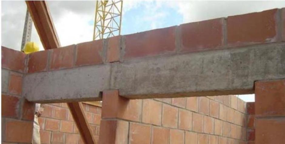
**Figura 08** - Exemplo em obra da utilização da verga pré-moldada.
