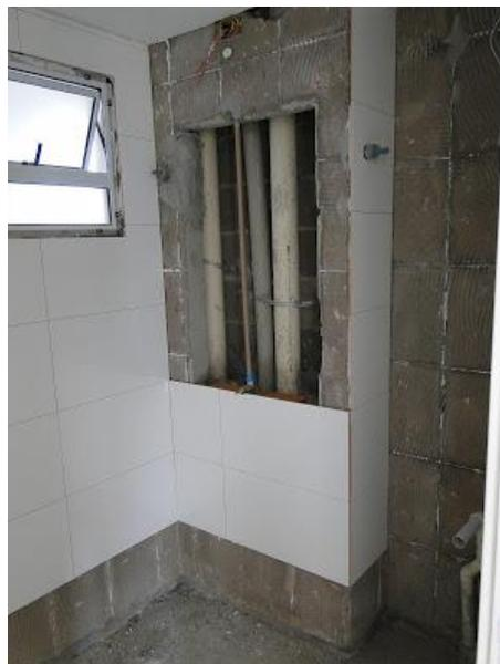
**Figura 24** - *Shaft* sobressaindo da parede.
