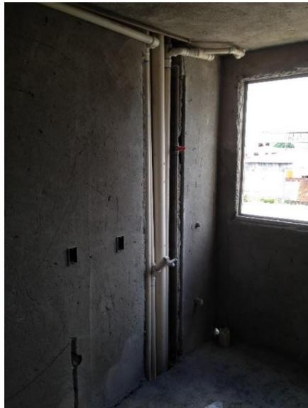
**Figura 25** - *Shaft* com a mesma espessura da parede.
