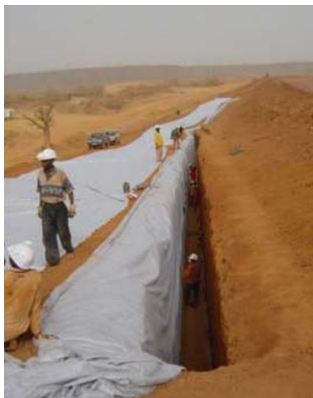
Figura 22: Utilização de geossintético como filtro na barragem de Samira.
