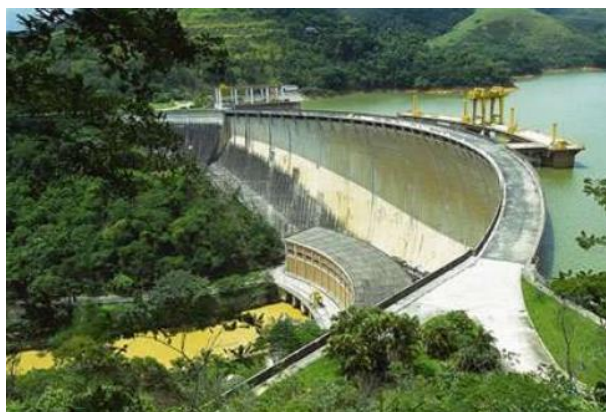
Figura 1: Barragem de concreto em arco, Barragem do Funil – RJ.
