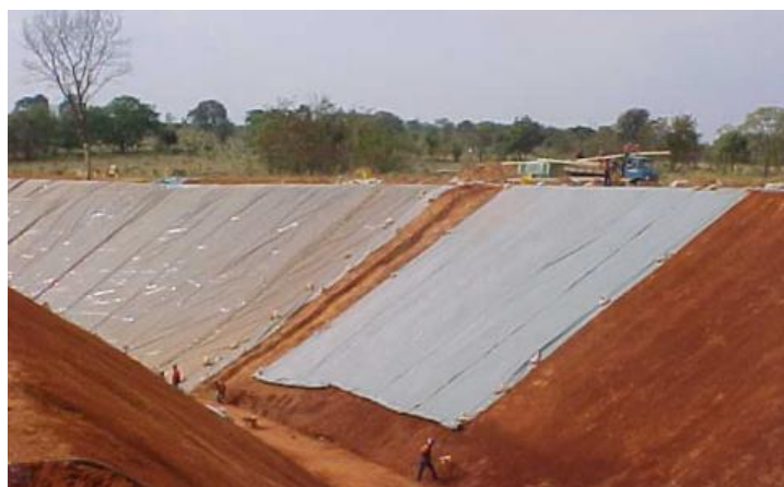
Figura 13: Instalação de geotêxtil em talude.
