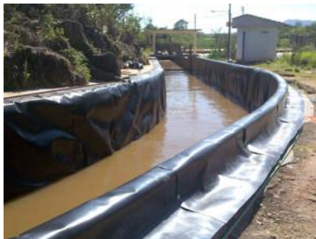
Figura 15: Geomembrana em um canal
