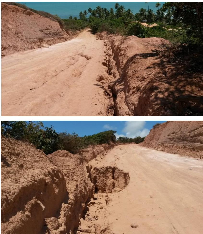
*Figura 10* - Processo erosivo em andamento no acesso à praia de Coqueirinho, chegando a configurar ravinas em determinados trechos, dada sua profundidade.
