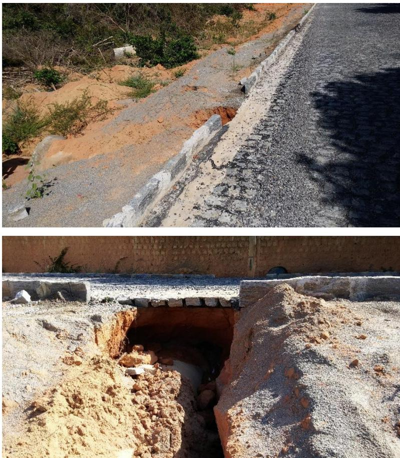
*Figura 14 - Ruptura da base do pavimento rígido no acesso à praia de Coqueirinho.*
