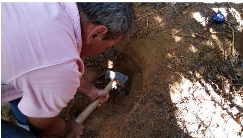
Figura 5 – Coleta de amostra indeformada em área adjacente ao acesso, com presença de matéria orgânica (estacionamento local)
