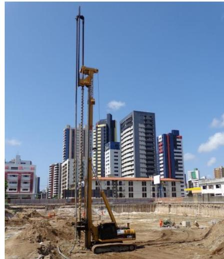
Figura 07: Edifício em hélice contínua
