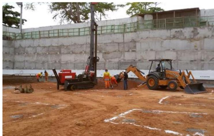
Figura 09: Edifício em estacas escavadas
