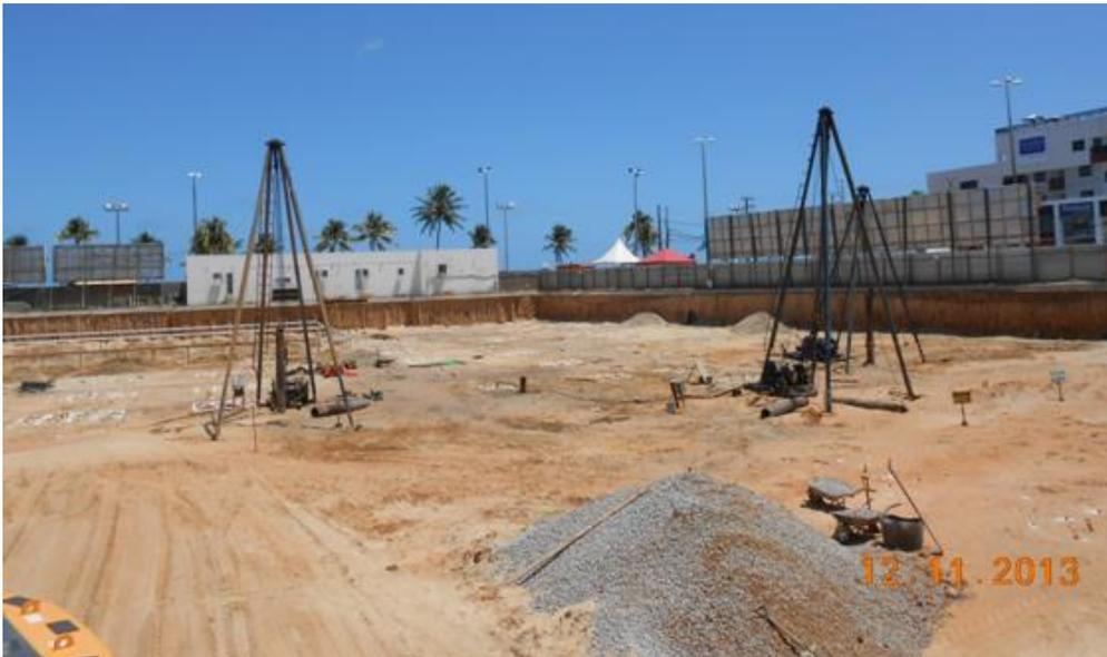
Figura 06: Execução das estacas de compactação
