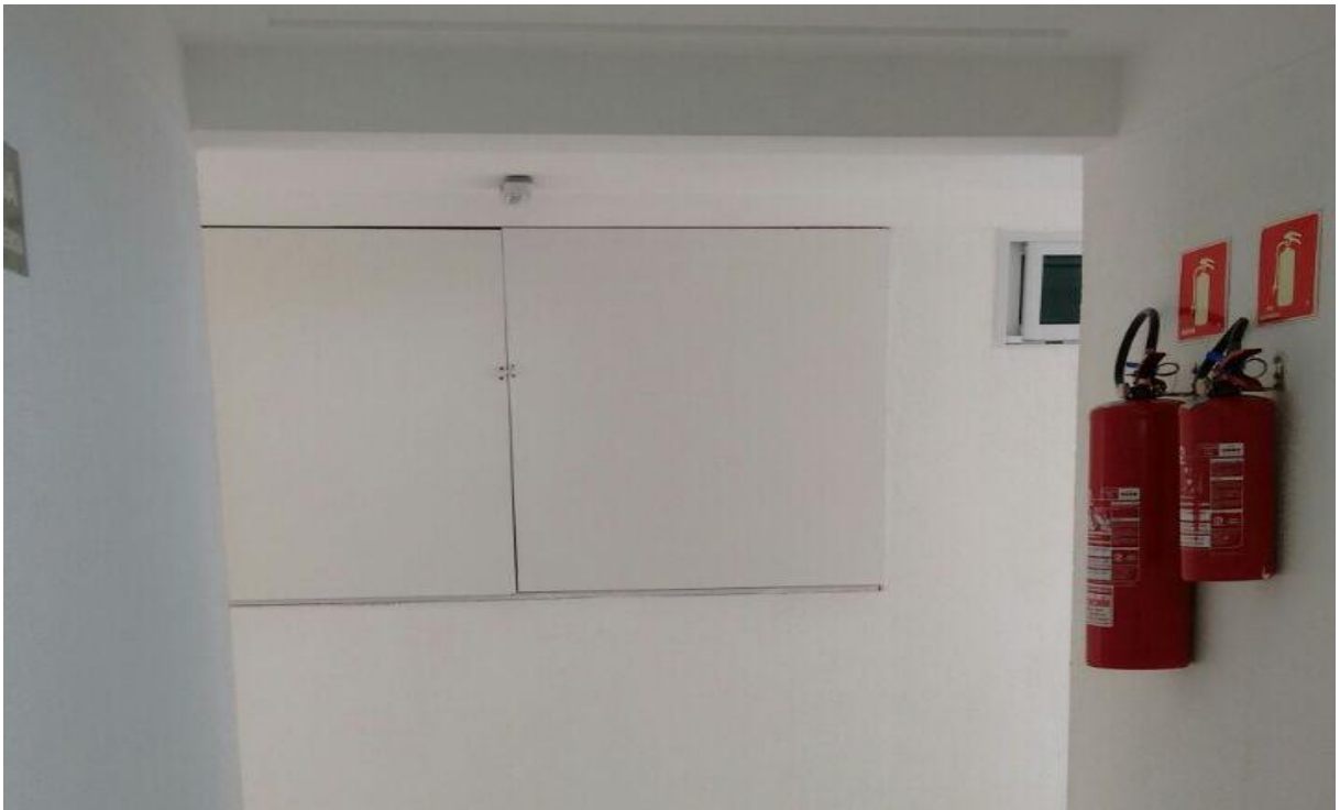
Figura 10: Extintores de Incêndio de acordo com a NR18
