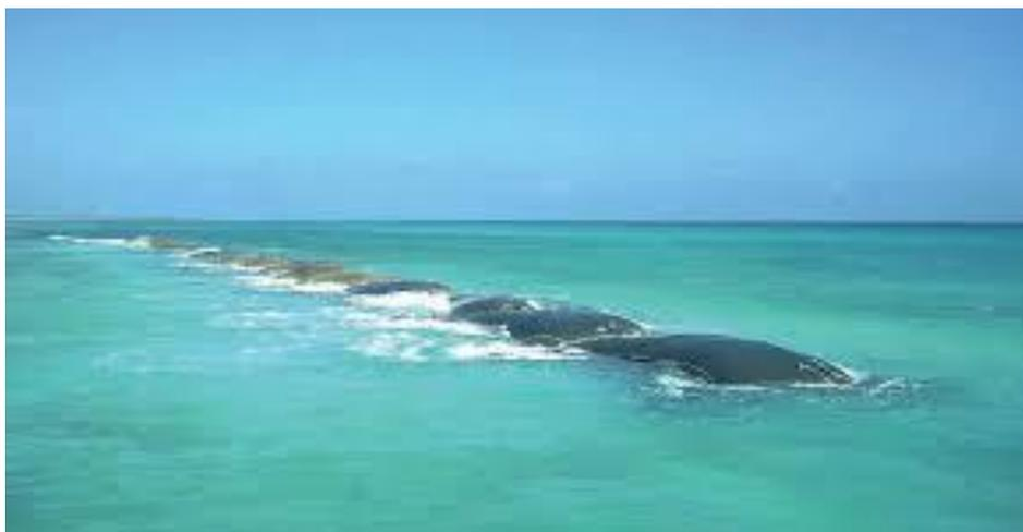
Figura 36: Geotubos com função de quebra-mar em mar aberto.
