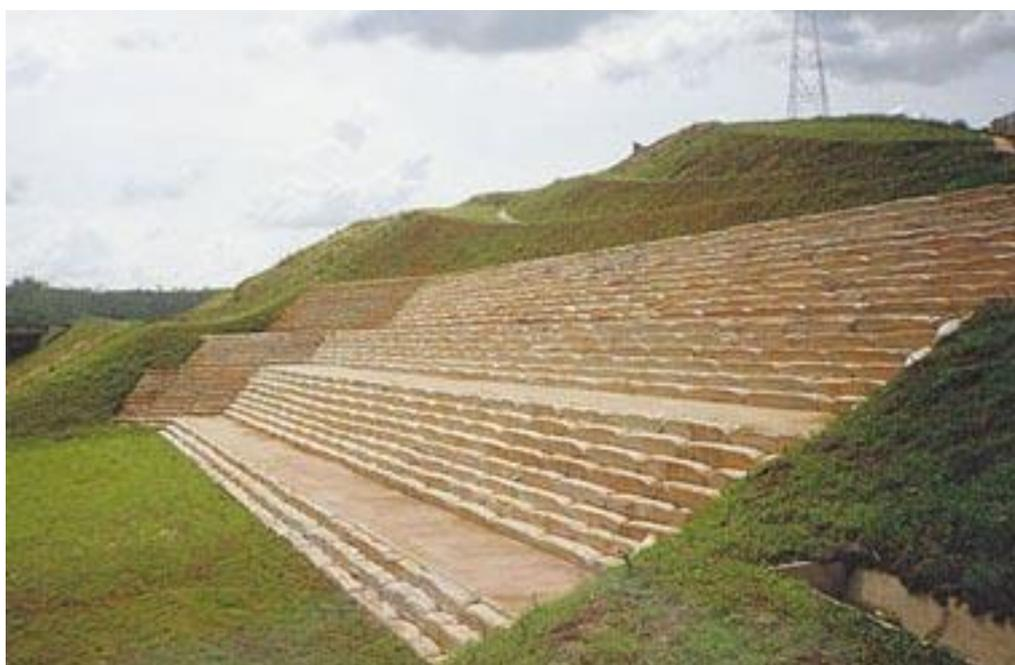
Figura 38: Contenção de talude na Rodovia Ayrton Senna (SP) com BOLSACRETO<sup>®</sup>
