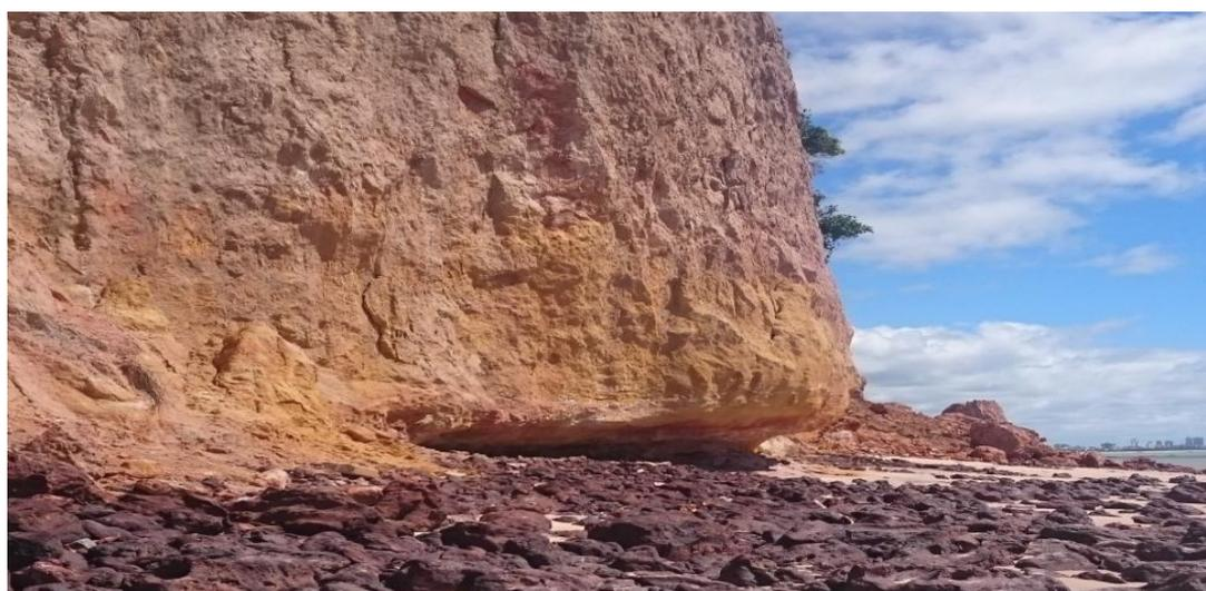
Figura 26: Ação da erosão marinha na base do talude.
