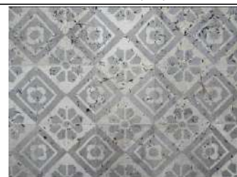
Imagem 53: Ladrilho hidráulico no piso do Setor de Lavagem (14).
