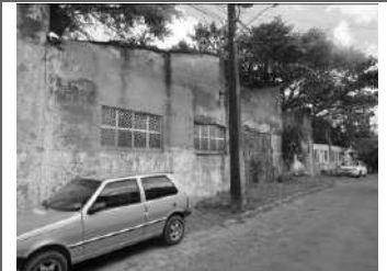
Imagem 03: Fachada frontal do edifício Nordeste da antiga IVS.
