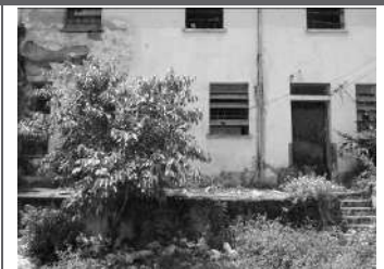
Imagem 09: Fachada lateral interna (ao lote) do edifício Leste da antiga IVS. Destaca-se as esquadrias do térreo.
