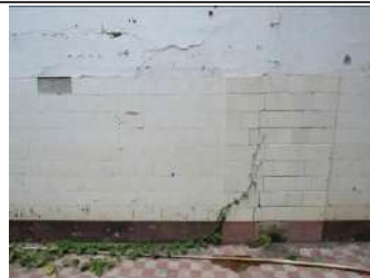
Imagem 44: Revestimento cerâmico nas paredes externas do banheiro (10).
