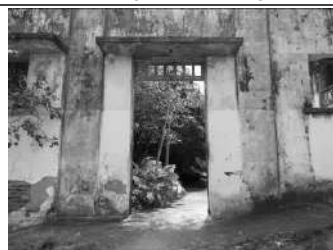
Imagem 31: Acesso principal ao edifício Norte da antiga IVS.
