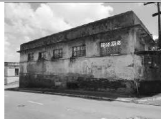
Imagem 20: Fachada frontal do edifício Oeste, rua da República. Destaca-se o cobogó utilizado para vedação das aberturas
