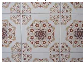
Imagem 55: Revestimento cerâmico na parede do banheiro (21).
