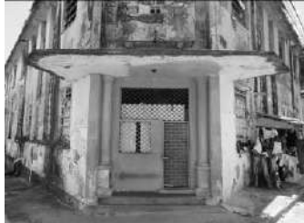
Imagem 10: Fachada frontal principal do edifício Leste da antiga IVS. Destaca-se a entrada principal da ex-empresa.
