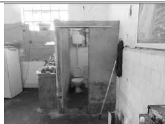
Imagem 07: Setor do Guaraná (13). Destaca-se a construção de um banheiro.
