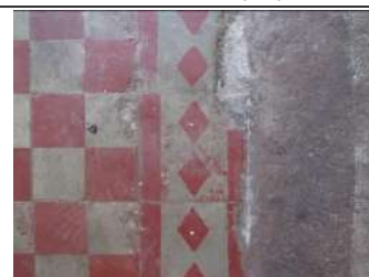
Imagem 49: Ladrilho hidráulico no piso Setor do Xarope (19).
