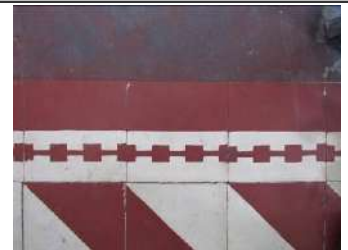
Imagem 46: Ladrilho hidráulico no piso do Laboratório (18).
