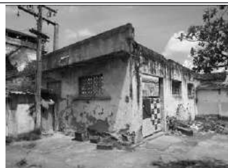
Imagem 23: Fachadas laterais internas (ao lote) edifício Oeste da antiga IVS. Destaca-se a platibanda, a grande
