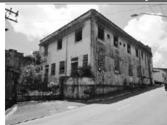
Imagem 07: Fachadas laterais do edifício Leste da antiga IVS, rua da República.
