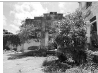
Imagem 04: Fachada frontal interna (ao lote) do edifício Norte da antiga IVS.
