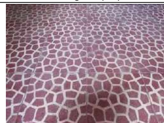
Imagem 57: Ladrilho hidráulico no piso do depósito do Pátio (Carga/Descarga) (02).
