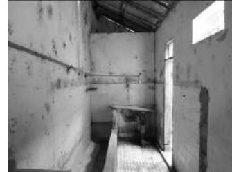
Imagem 12: Vista interna do banheiro (10).
