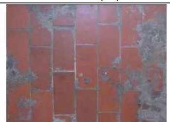
Imagem 54: Revestimento cerâmico no piso Setor do Guaraná (13).
