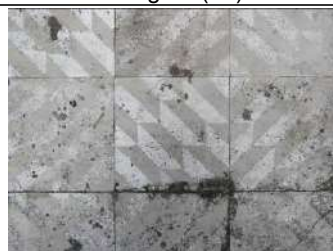
Imagem 56: Ladrilho hidráulico no piso do Setor de Lavagem (14).
