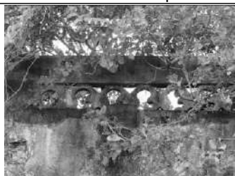
Imagem 30: Desenho de coroamento da fachada lateral esquerda do edifício Norte da antiga IVS.
