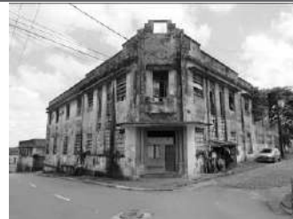
Imagem 02: Fachadas frontais do edifício Leste da antiga IVS.
