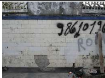
Imagem 43: Revestimento cerâmico nas paredes externas do banheiro (10).
