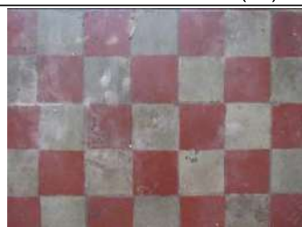
Imagem 48: Ladrilho hidráulico no piso Setor do Xarope (19).
