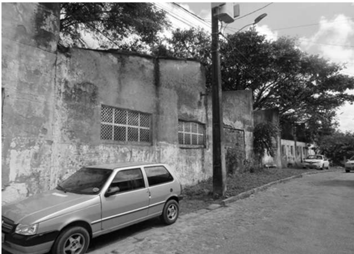
Imagem 04: Fachada frontal do edifício Nordeste da antiga Indústria Vinícola Sanhauá.
