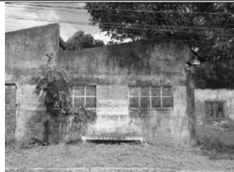
Imagem 15: Fachada frontal do edifício Nordeste da antiga IVS, rua Professora Analice Caldas. Destaca-se o cobogó utilizado na vedação das aberturas.
