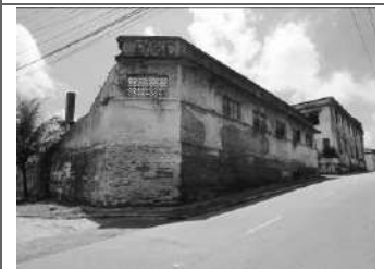
Imagem 05: Fachada frontal do edifício Oeste da antiga IVS.
