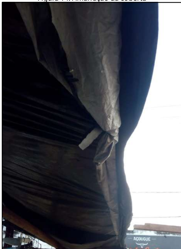
Figura 14: Amarração da cobertura
