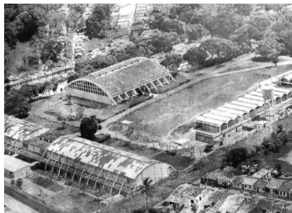
Figura 06 - Vista aérea do conjunto da escola-parque Centro Educacional Carneiro Ribeiro.
