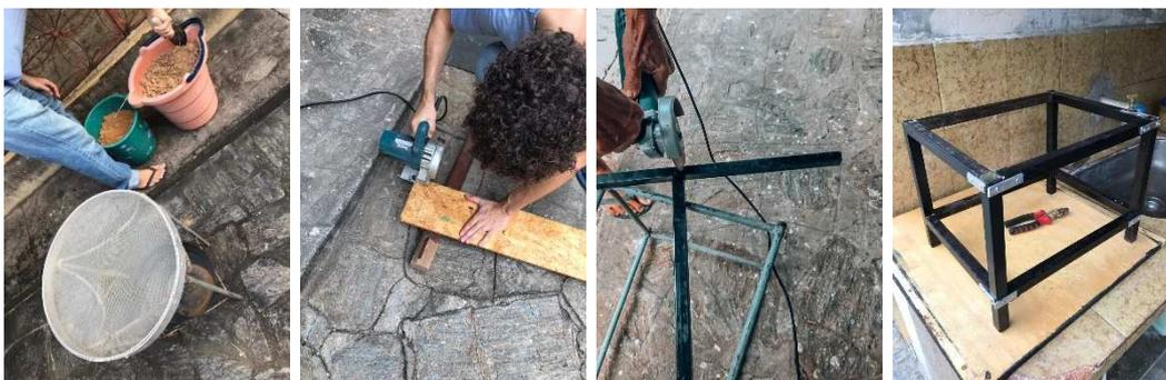
Legenda: Figura 1: Processo de destorar e peneira as amostras de terra. Figura 2: Construção da caixa para o teste de retração e preparação das fôrmas. Figura 3 e 4: Construção dos travamentos do taipal para compactação. Fonte: Autores
