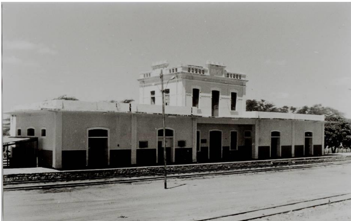
FIGURA 02: Estação Ferroviária de Mossoró por volta de 1950.
