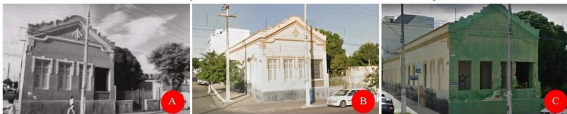
FIGURA 10: Edificação situada na Av. Rio Branco com a Av. Augusto Severo
