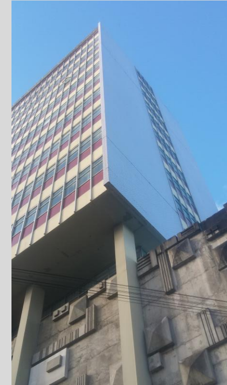
IMAGEM 18: Vista atual do edifício. Fonte: Acervo da equipe.
