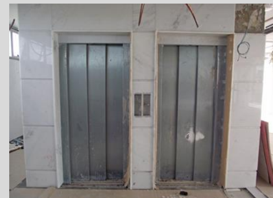
IMAGEM 25: Reforma dos elevadores. Fonte: revistaedificar.com.br/
