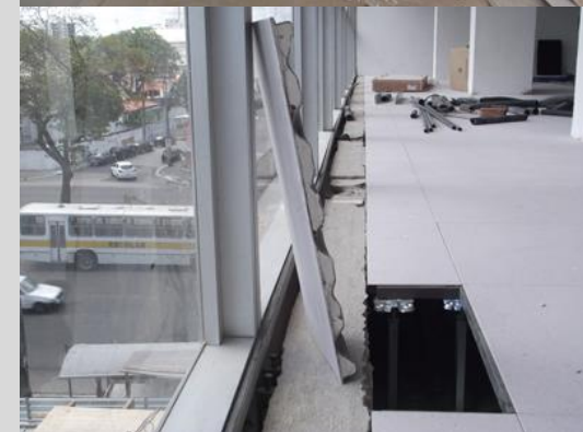
IMAGEM 26: Reforma das esquadrias e colocação de pisos flutuantes. Fonte: revistaedificar.com.br/
