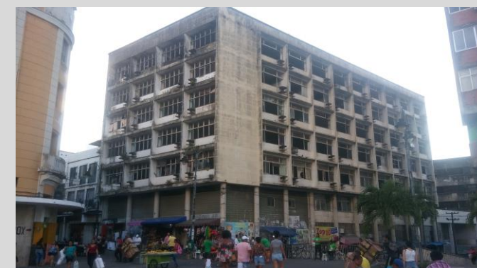
IMAGEM 02: Vista do Edifício IPASE, na Praça Vidal de Negreiros, dias atuais. Fonte: Acervo da equipe.
