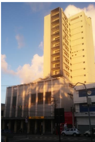
Figura 32: Fachada Oeste do Banco.
