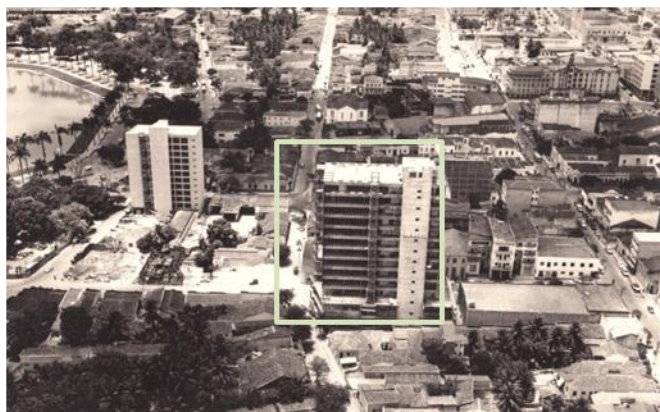
Figura 35: Edifício do INSS (marcado) visto próximo ao Parque Solón de Lucena.
