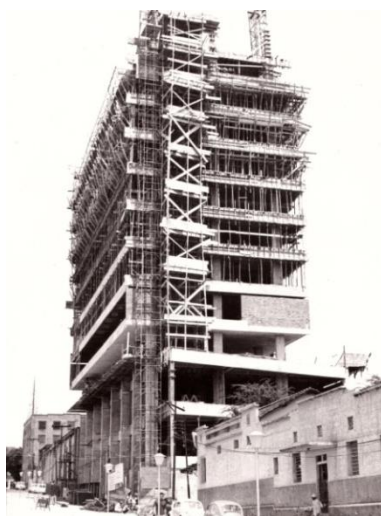
Figura 36: Edifício INSS em construção.
