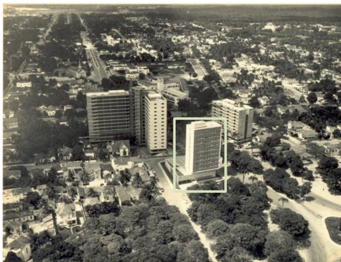
Figura 16: Vista da Antiga Reitoria (marcada na imagem) no Centro da cidade.
