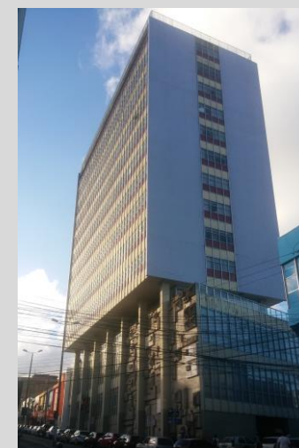
IMAGEM 12: Vista atual do edifício. Fonte: Acervo da equipe.
