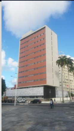
IMAGEM 22: Vista da fachada Oeste.
