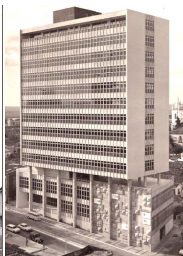
Figura 37: Fachada do edifício INSS.
