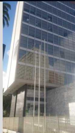
IMAGEM 23: Vista da fachada Leste.
