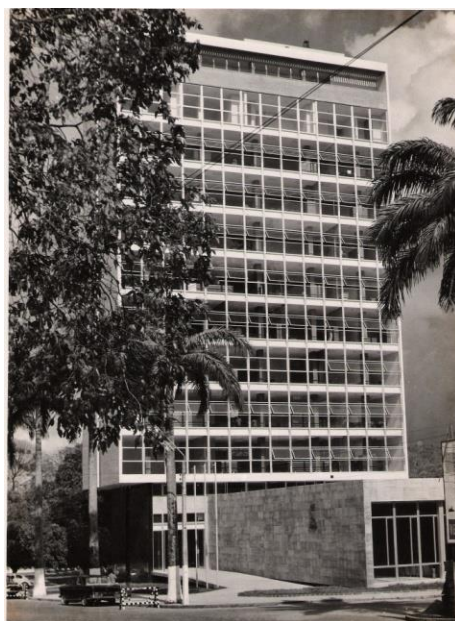
Figura 18: Fachada em cortina de vidro da Antiga Reitoria.
