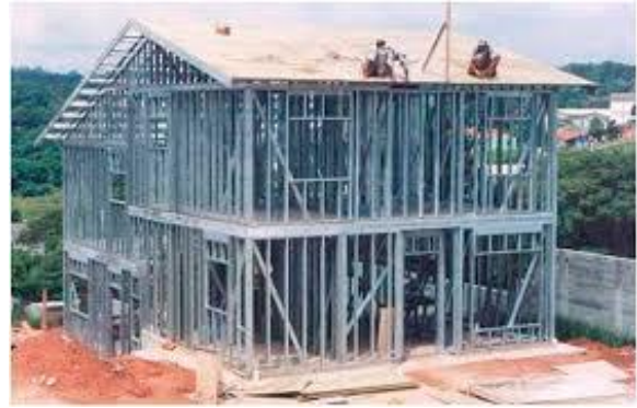
Figura 15: Exemplos de materiais de construções nas HIS, a primeira em bloco de tijolo cimento e à segunda em steel frame
