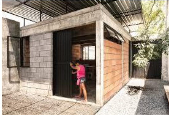
Figura 15: Exemplos de materiais de construções nas HIS, a primeira em bloco de tijolo cimento e à segunda em steel frame
