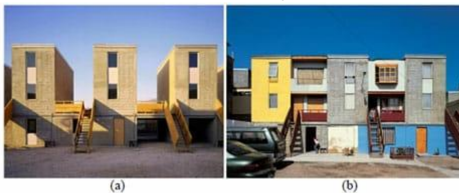
Figura 18: Conjuntos habitacionais Quinta Monroy, Chile. (A) Fachada original. Fachada com intervenção dos moradores
